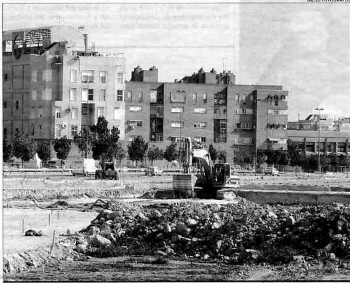
Las obras de urbanización del sector donde se asentará el centro comercial de El Corte Inglés ya han dado comienzo
